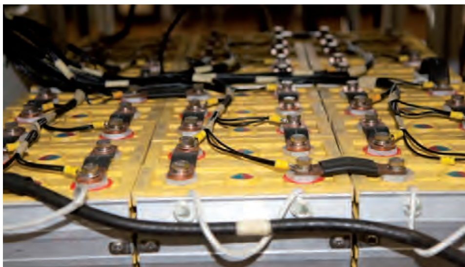
Banco de baterias de lítio, usadas no Veeco
