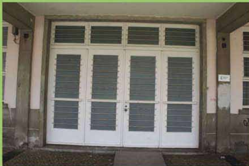
Instituto Histórico de Educação: um depósito de portas fechadas
