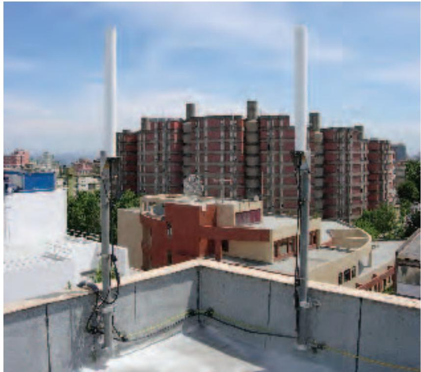
Vista de duas antenas omnidireccionais da estação base WiMAX
